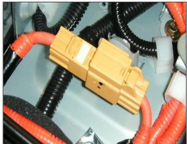
Example HV Wiring (orange)
